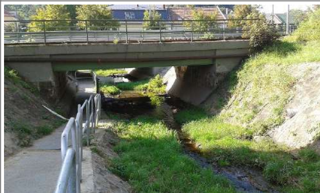
Az acélgyári patak és a vasút kereszteződése
