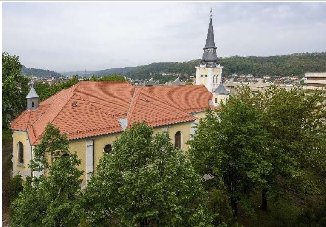
Főplébánia templom, tetőfelújítás 2017-ben
