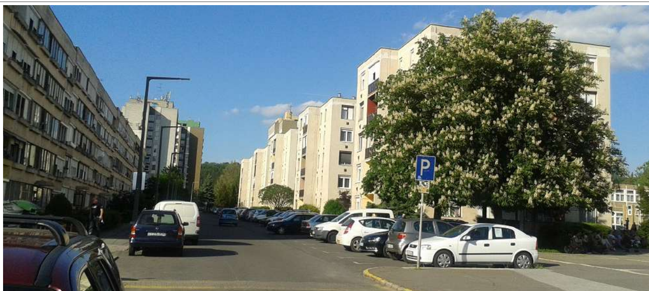
Ybl Miklós út, jobbra a kohóabsalak blokkos, az út végén és balra a monolit alagútszalus vasbeton építésű társasházak
