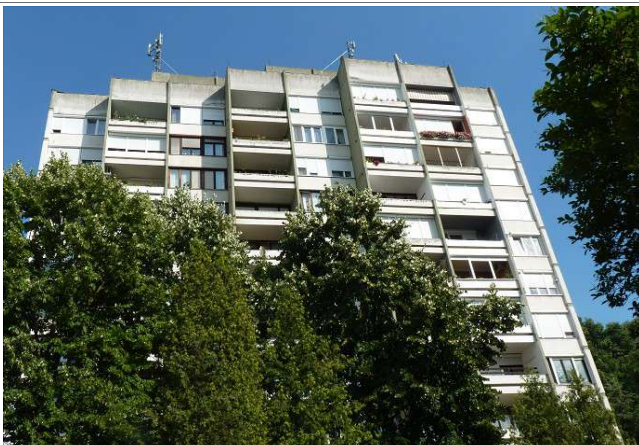
Alagútsalus építési technológiával épült társasház, Kistarján út
