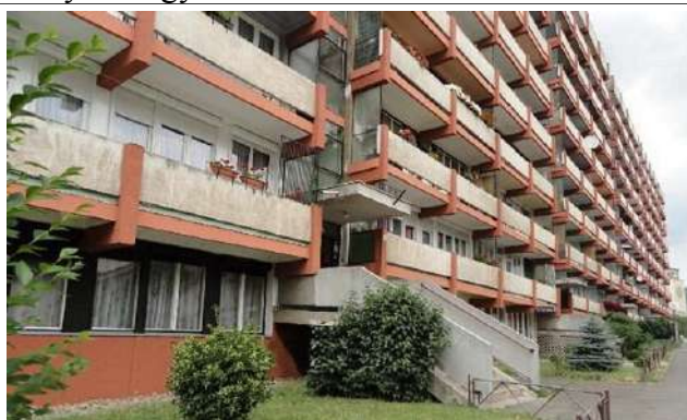
Keretvázás-erkélyes társasház, részleges homlokzati színváltoztatás, Március 15. út
